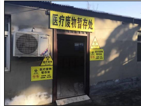
现有工程医疗废物暂存间
